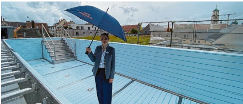
Fototermin mit Regenschirm im trockenen Hotelpool: Bleona Tafaj testet das 14 mal drei Meter große Becken, das frisch eingebaut ist. Foto: Michael Hörmann
